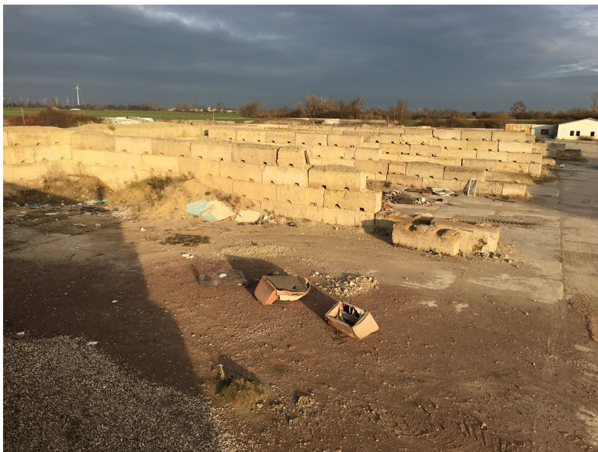
Bild 28: Sanierungsfläche, Blickrichtung Nordwest
