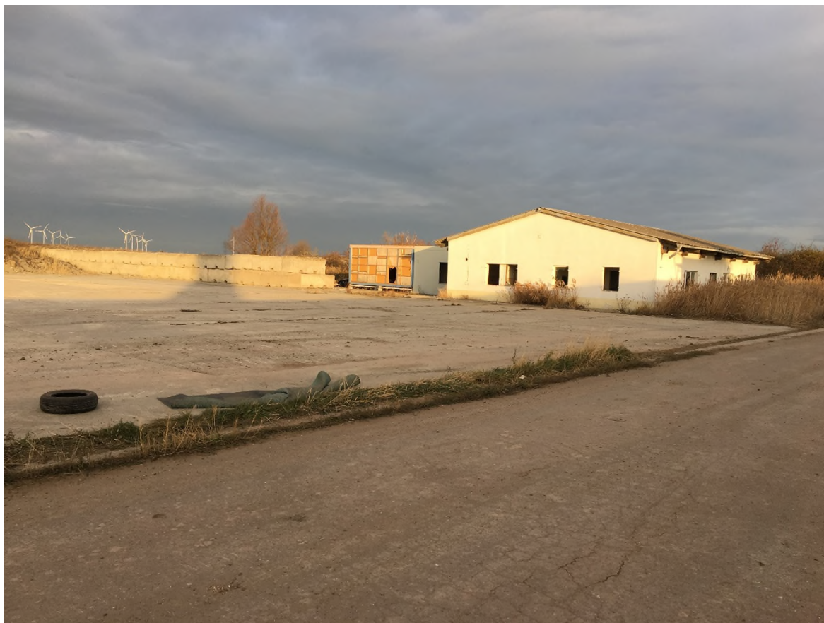
Bild 1: ehem. Sozialgebäude an nordöstlicher Sanierungsgrenze, Blickrichtung Nordwest
