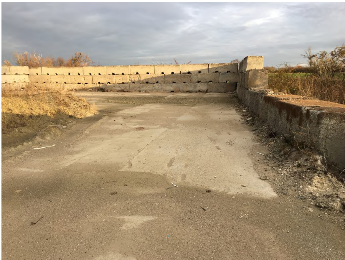
Bild 14: Nördliche Sanierungsgrenze, Blickrichtung Nord
