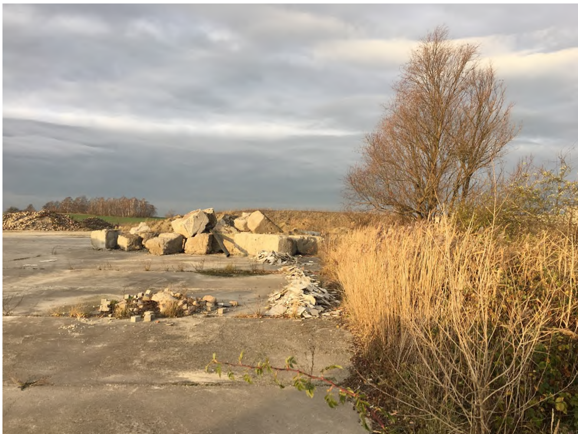
Bild 12: Nördliche Sanierungsgrenze, Blickrichtung West
