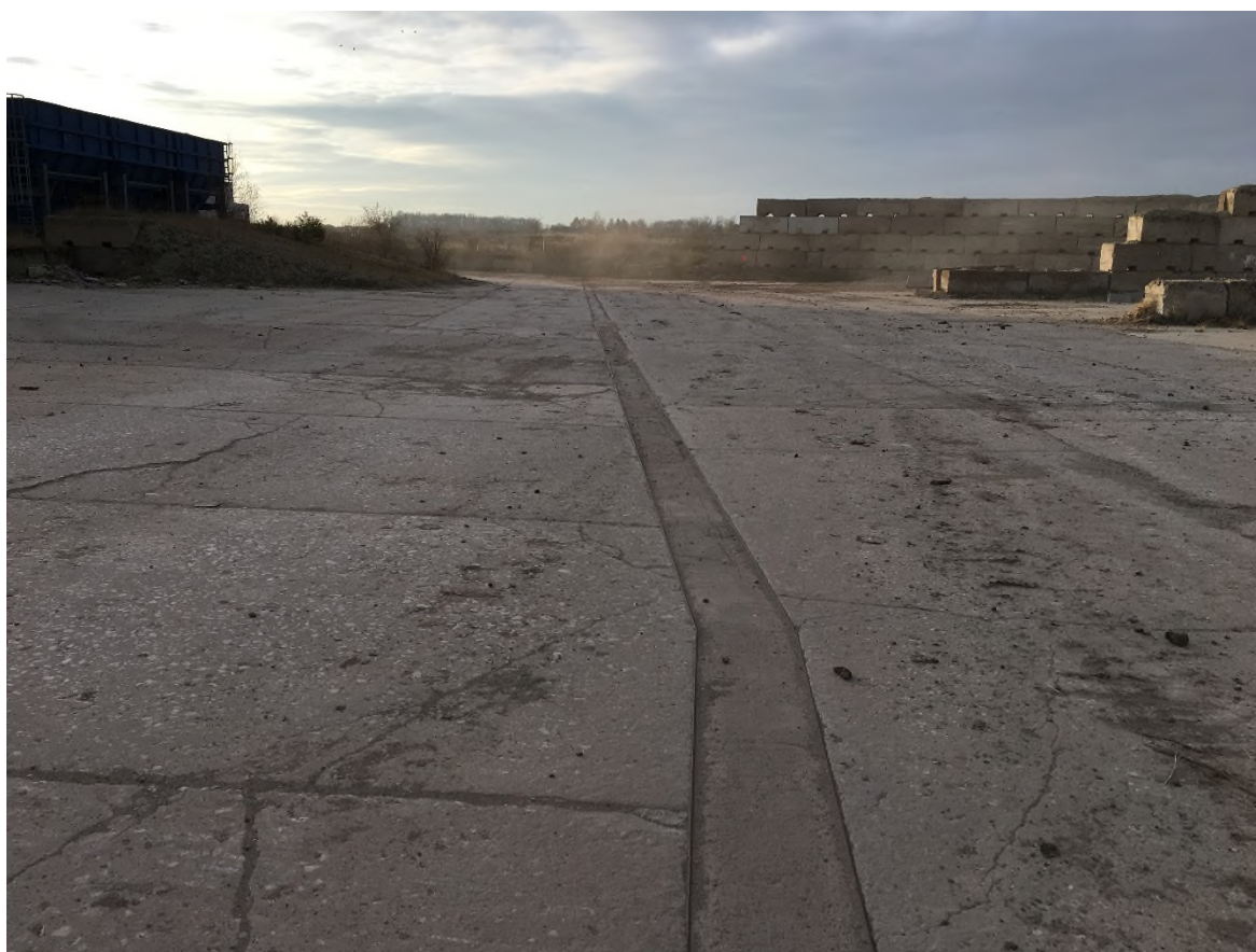
Bild 32: Östliche Sanierungsgrenze, Blickrichtung Süd
