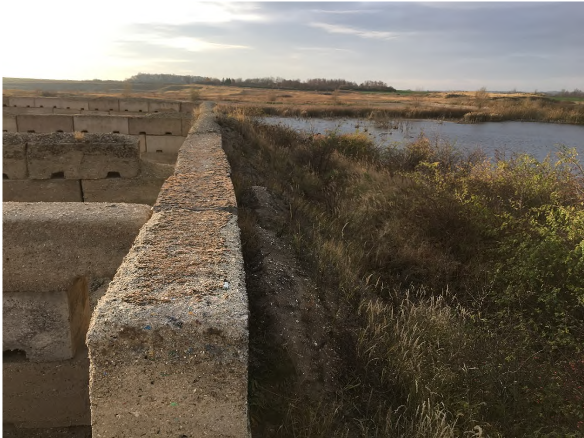
Bild 23: Südliche Sanierungsgrenze, Blickrichtung Süd
