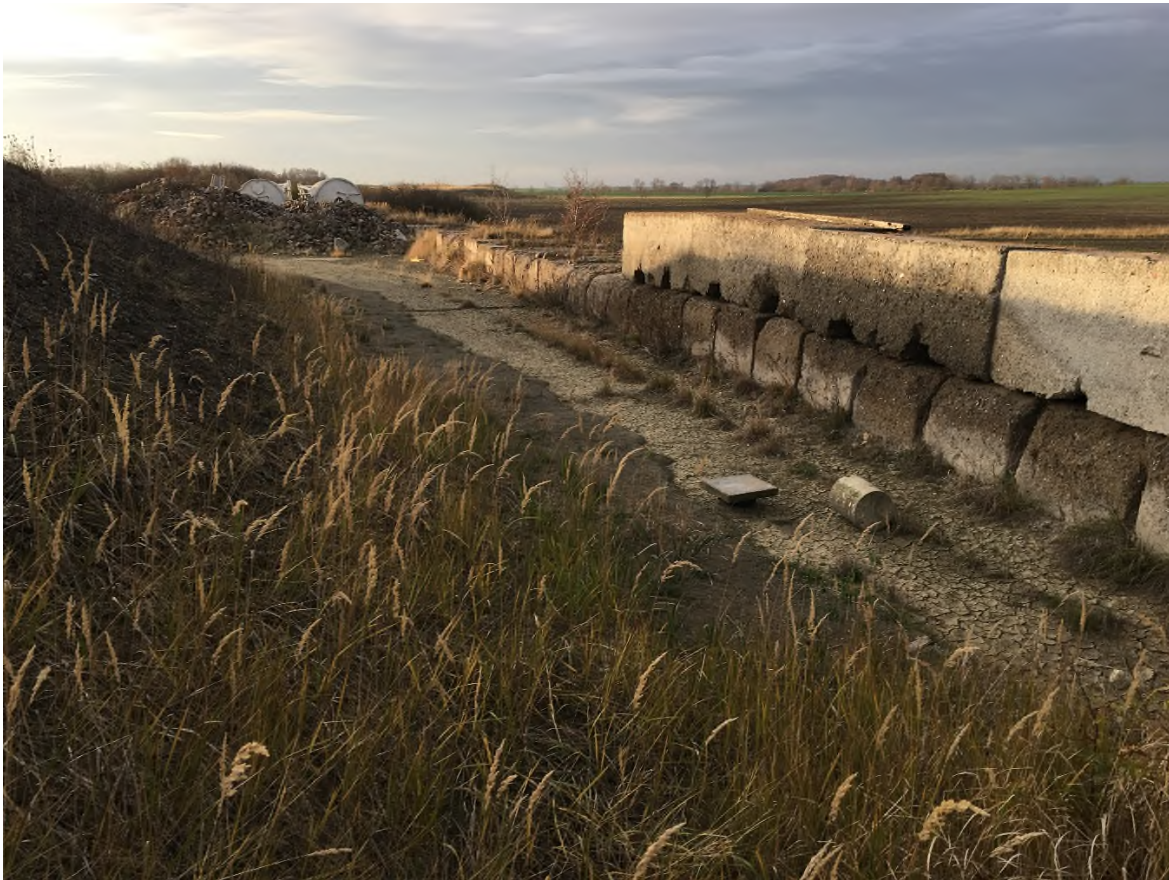
Bild 15: Westliche Sanierungsgrenze, Blickrichtung Südwest
