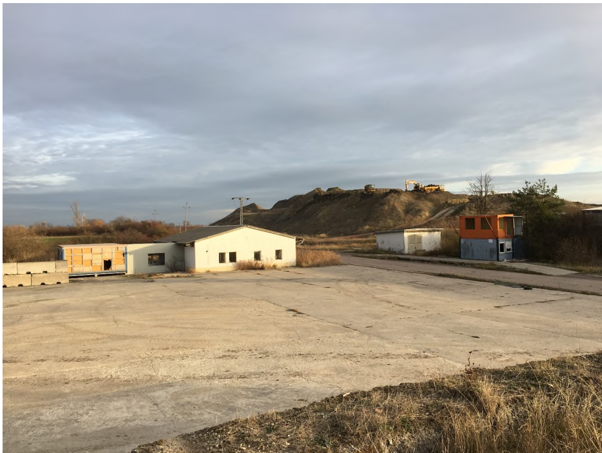
Bild 22: Südliche Sanierungsgrenze, Blickrichtung Nordost
