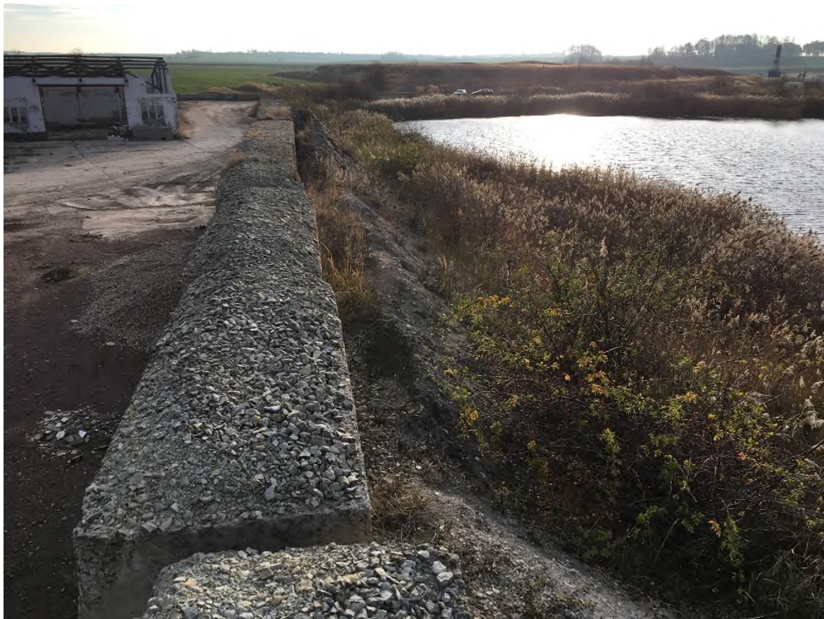
Bild 24: Südliche Sanierungsgrenze, Blickrichtung Südost
