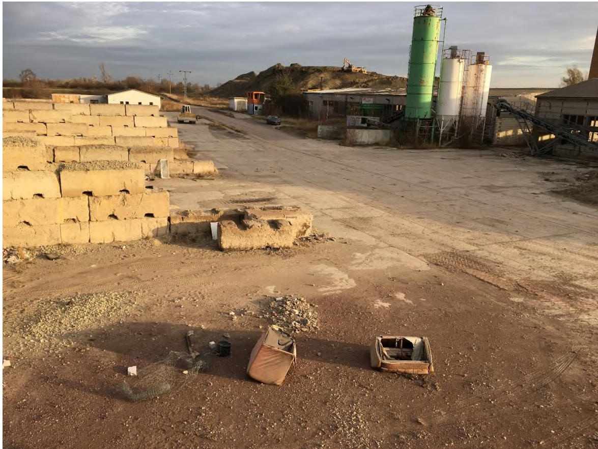
Bild 25: Östliche Sanierungsgrenze, Blickrichtung Nordost
