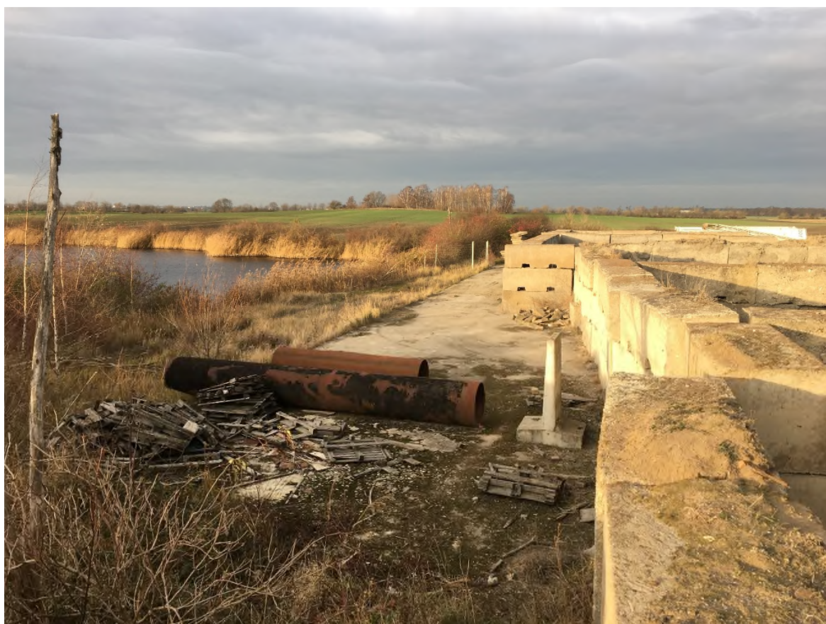
Bild 20: Südliche Sanierungsgrenze, Blickrichtung West
