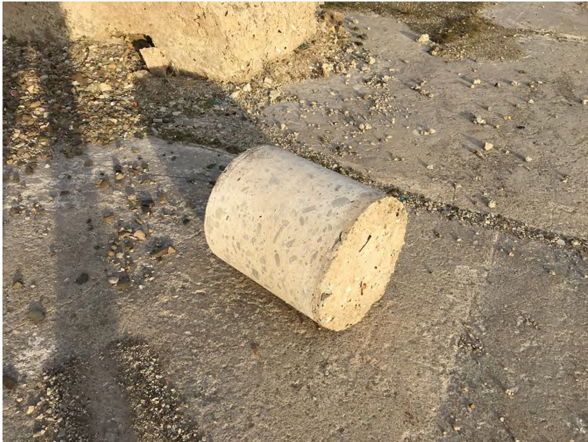
Bild 29: Bohrkern der vorh. Oberflächenversiegelung mit Anhaftungen von Müllbeton
