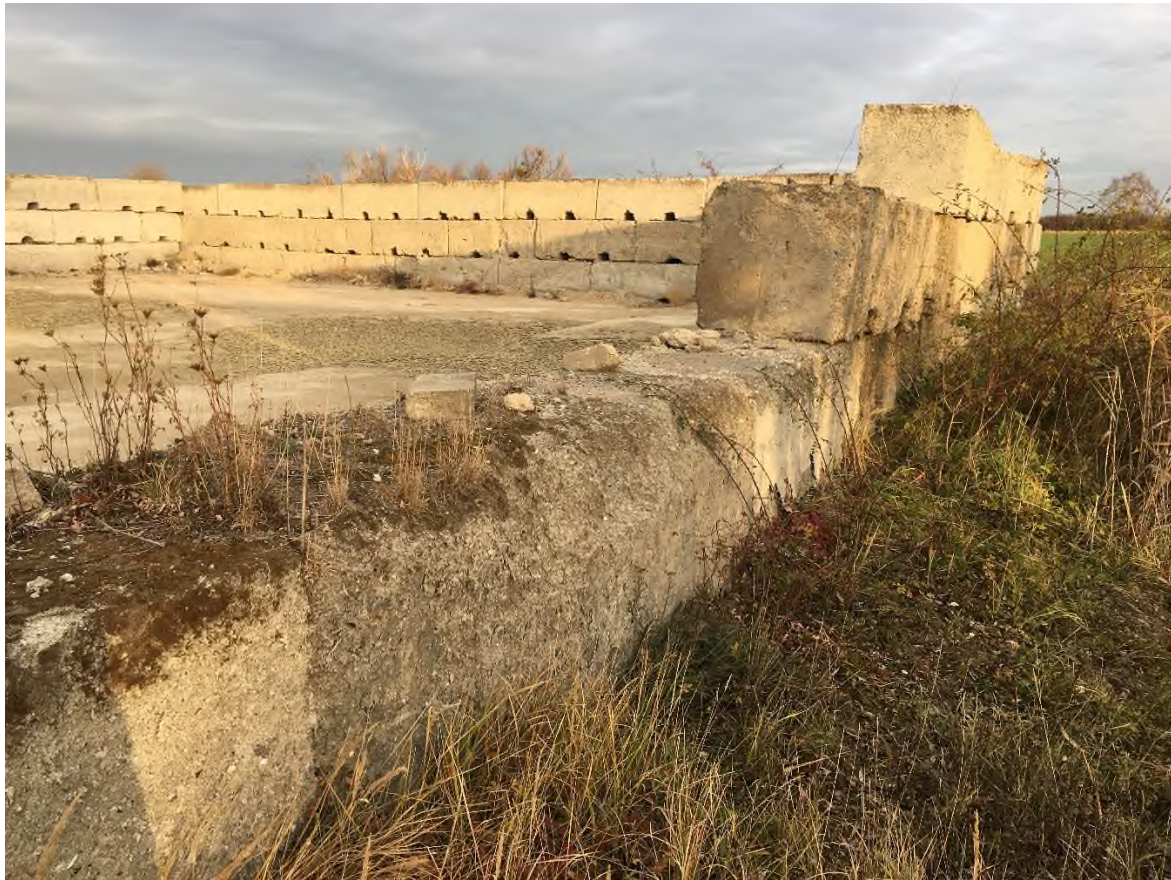
Bild 13: Nördliche Sanierungsgrenze, Blickrichtung Nordwest
