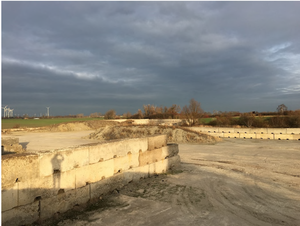
Bild 21: Südliche Sanierungsgrenze, Blickrichtung Nordwest
