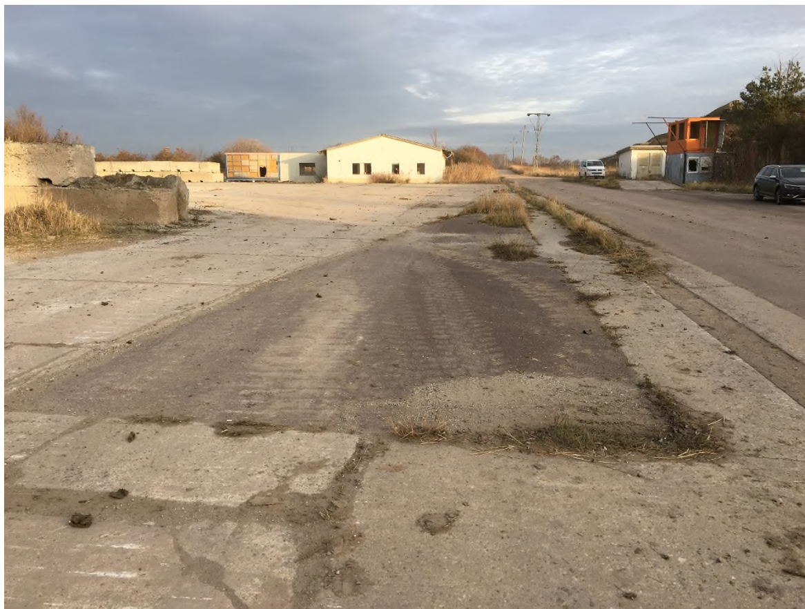
Bild 31: Östliche Sanierungsgrenze, Blickrichtung Nord
