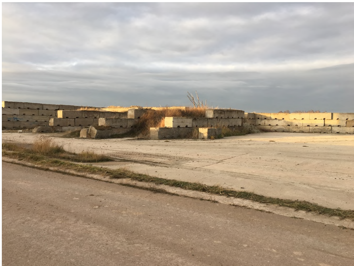
Bild 3: östliche Sanierungsgrenze, Blickrichtung Südwest
