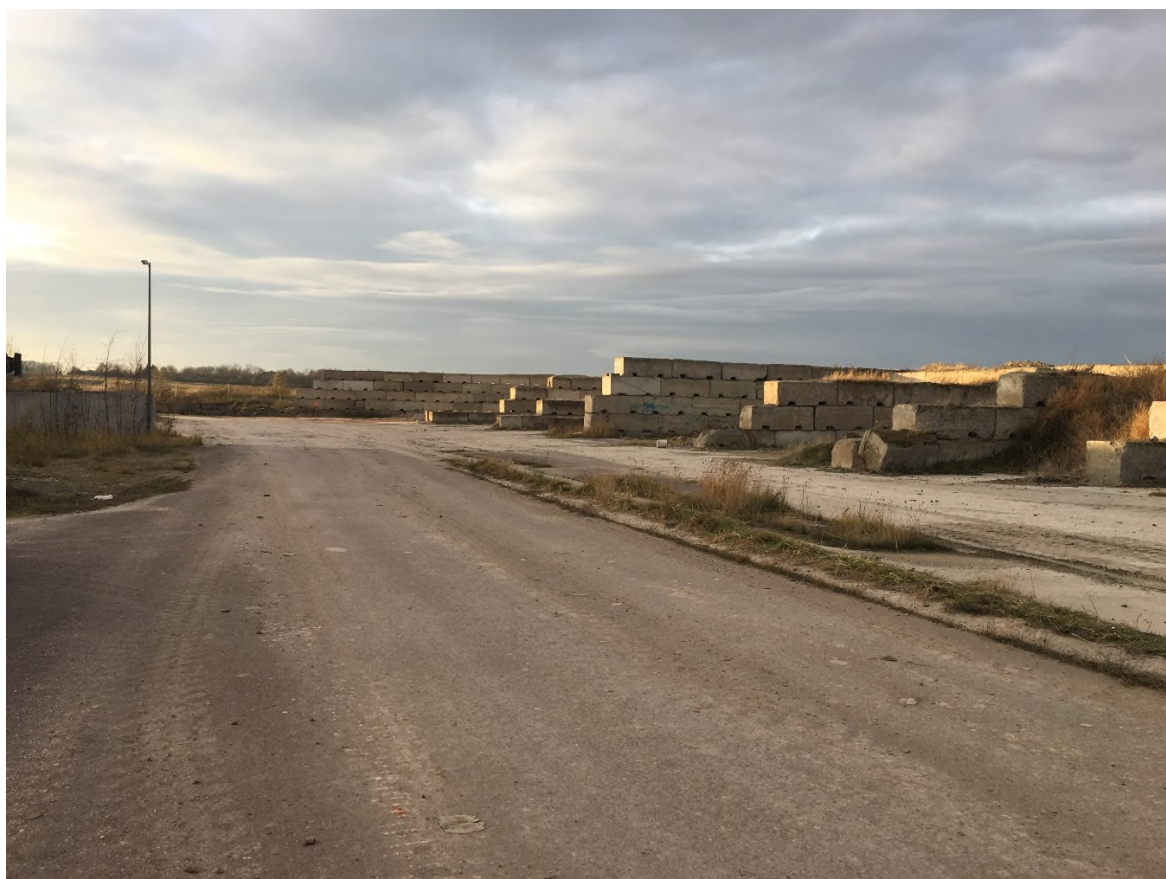
Bild 4: Östliche Sanierungsgrenze, Blickrichtung Süd
