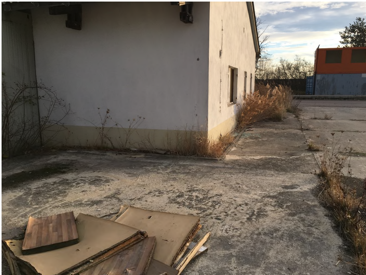
Bild 8: Anschluss Oberflächenversiegelung an ehem. Sozialgebäude, Blickrichtung Ost
