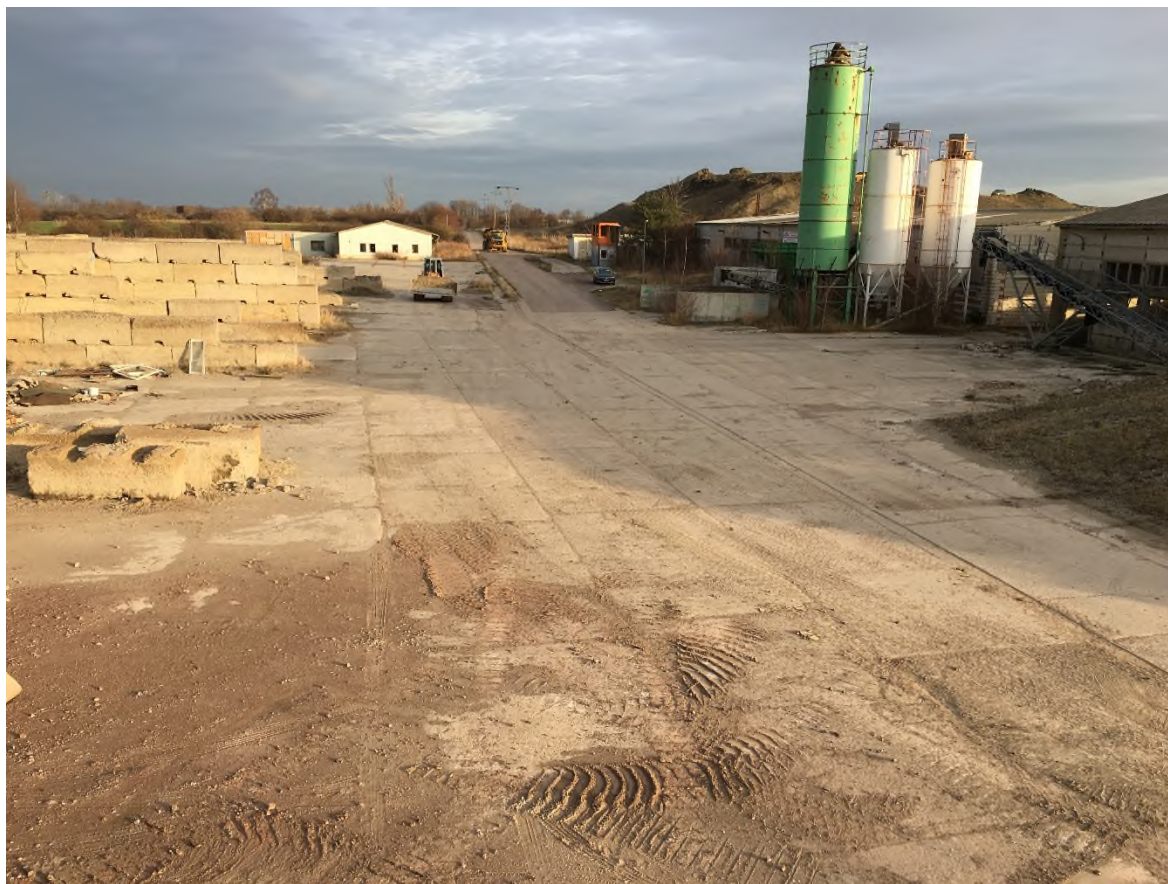
Bild 27: Östliche Sanierungsgrenze, Blickrichtung Nord
