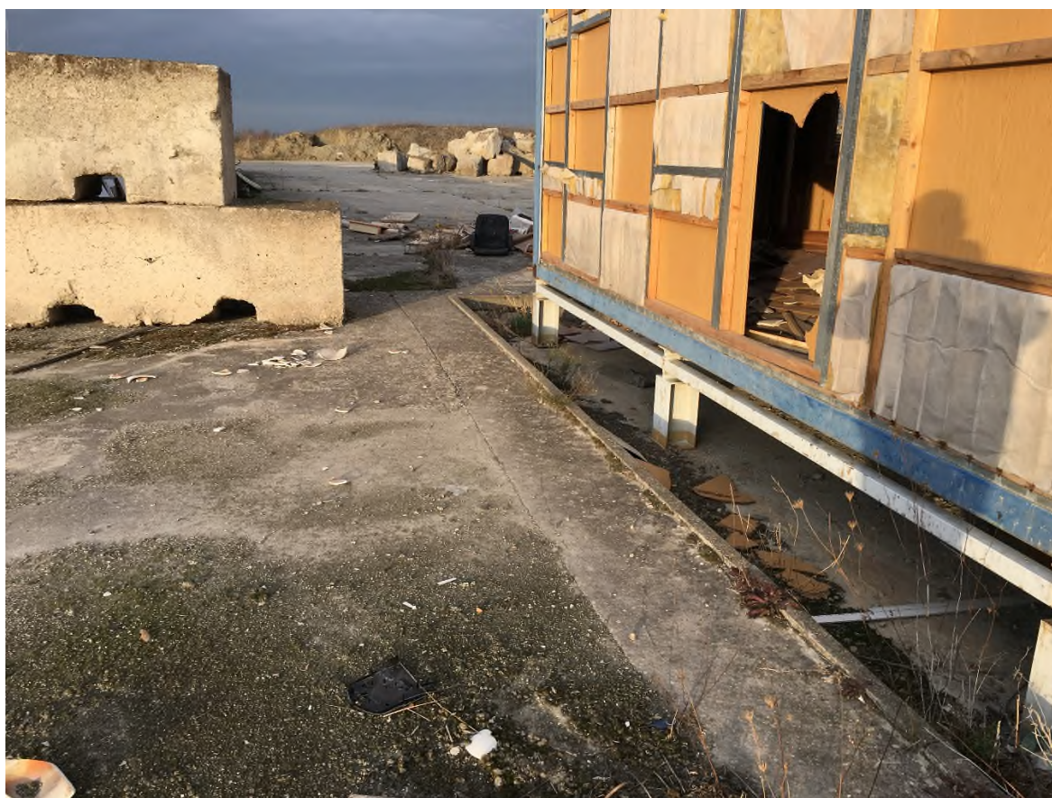
Bild 9: Anschluss Oberflächenversiegelung an ehem. Sozialgebäude, Blickrichtung West
