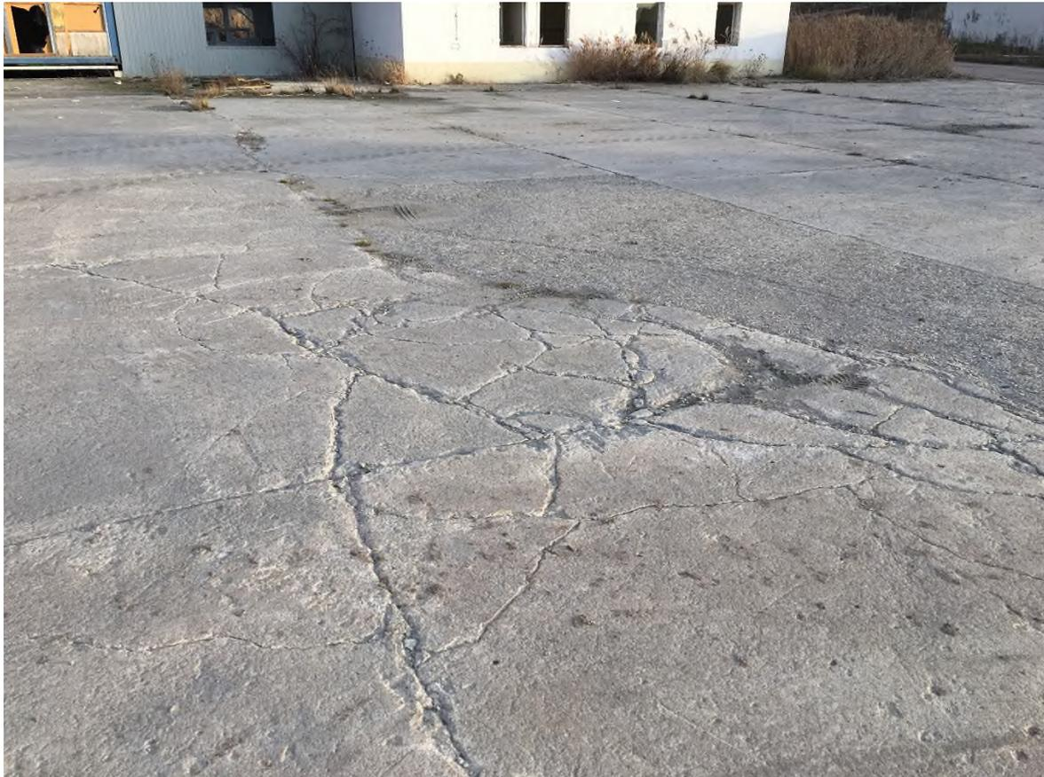
Bild 7: Risse im Beton der vorh. Oberflächenversiegelung, Blickrichtung Nord
