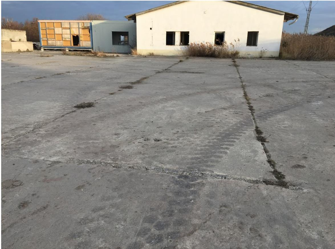
Bild 5: Fugen im Beton der vorh. Oberflächenversiegelung, Blickrichtung Nord
