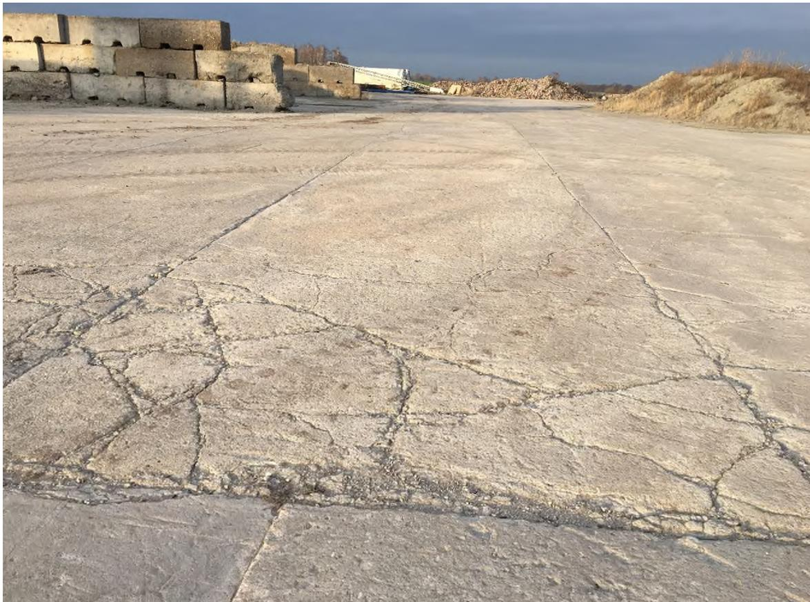
Bild 6: Risse im Beton der vorh. Oberflächenversiegelung, Blickrichtung West
