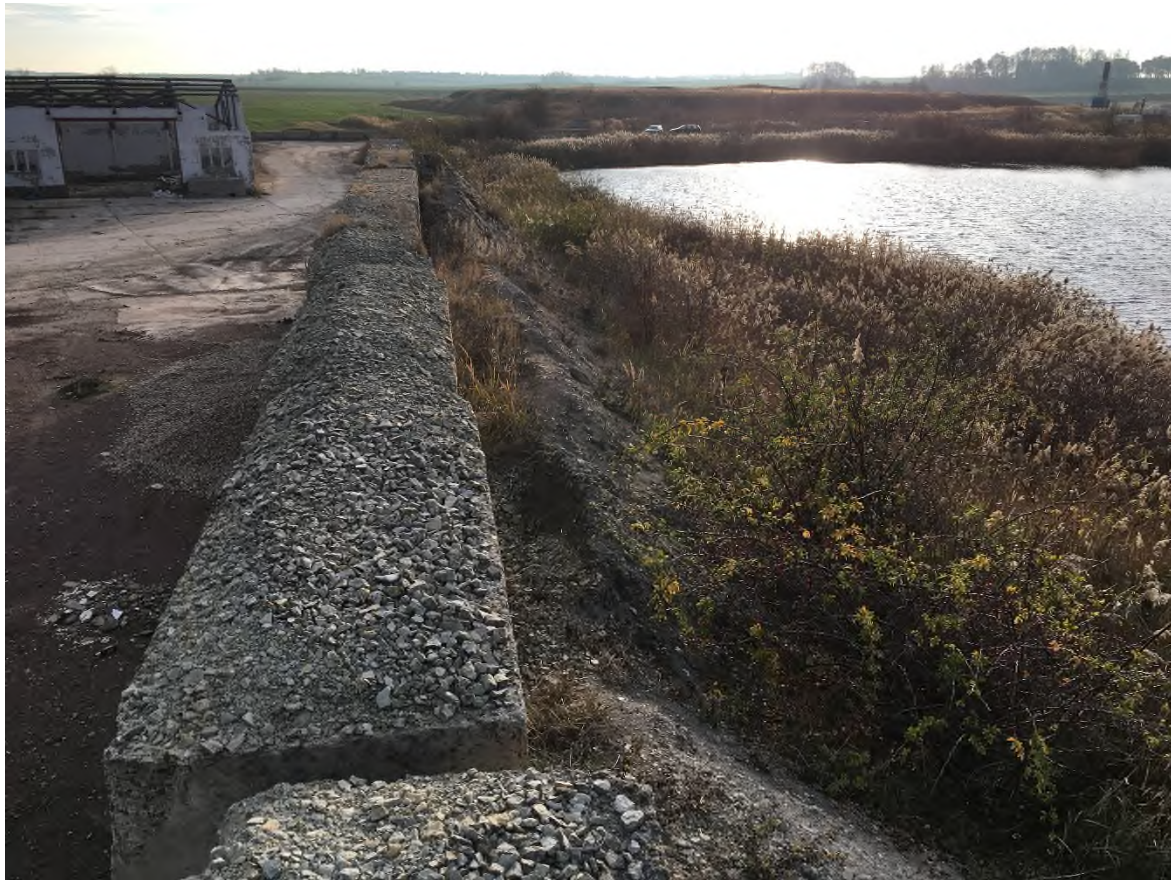
Bild 13: Südliche Sanierungsgrenze, Blickrichtung Südost, Stapelelemente teilweise entfernt
