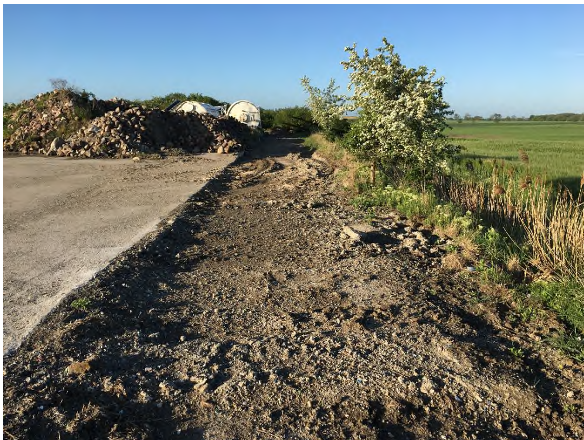
Bild 7: Westliche Sanierungsgrenze, Blickrichtung Süd (Hinweis: Haufwerk wurde entsorgt)
