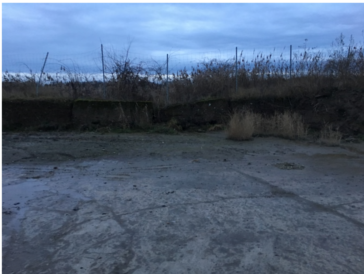
Bild 6: Müllbetonsteine, Südliche Sanierungsgrenze
