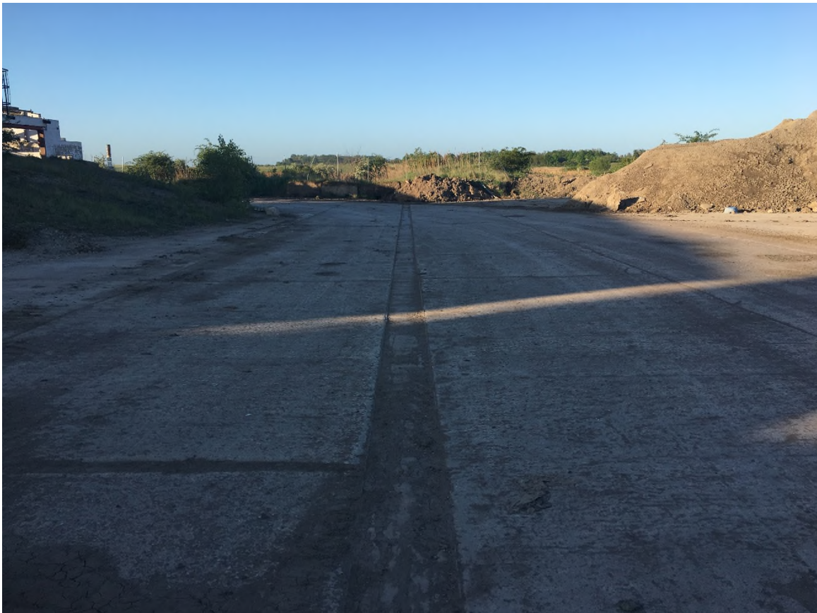
Bild 16: Östliche Sanierungsgrenze, Blickrichtung Süd (Hinweis: Haufwerk wurden teilweise entsorgt)
