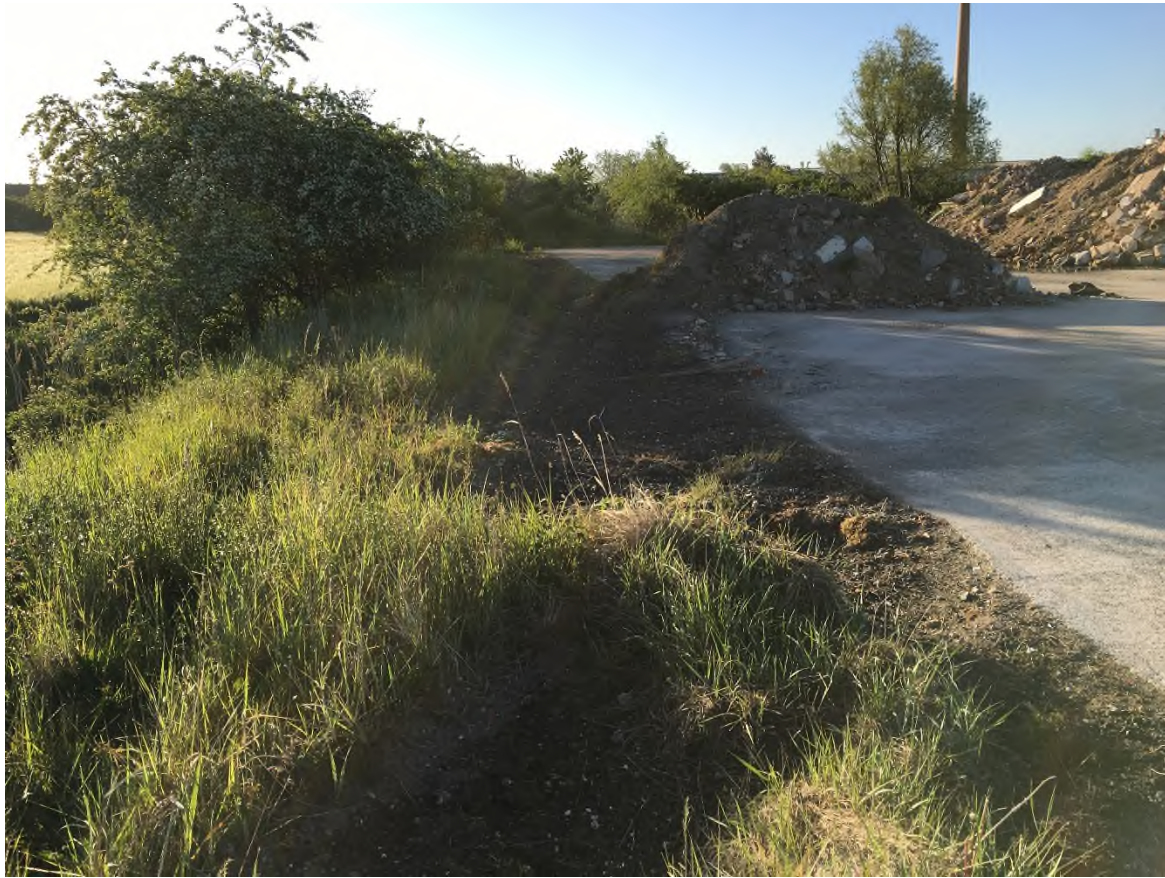
Bild 11: Nördliche Sanierungsgrenze, Blickrichtung Ost (Hinweis: Haufwerk wurde entsorgt)
