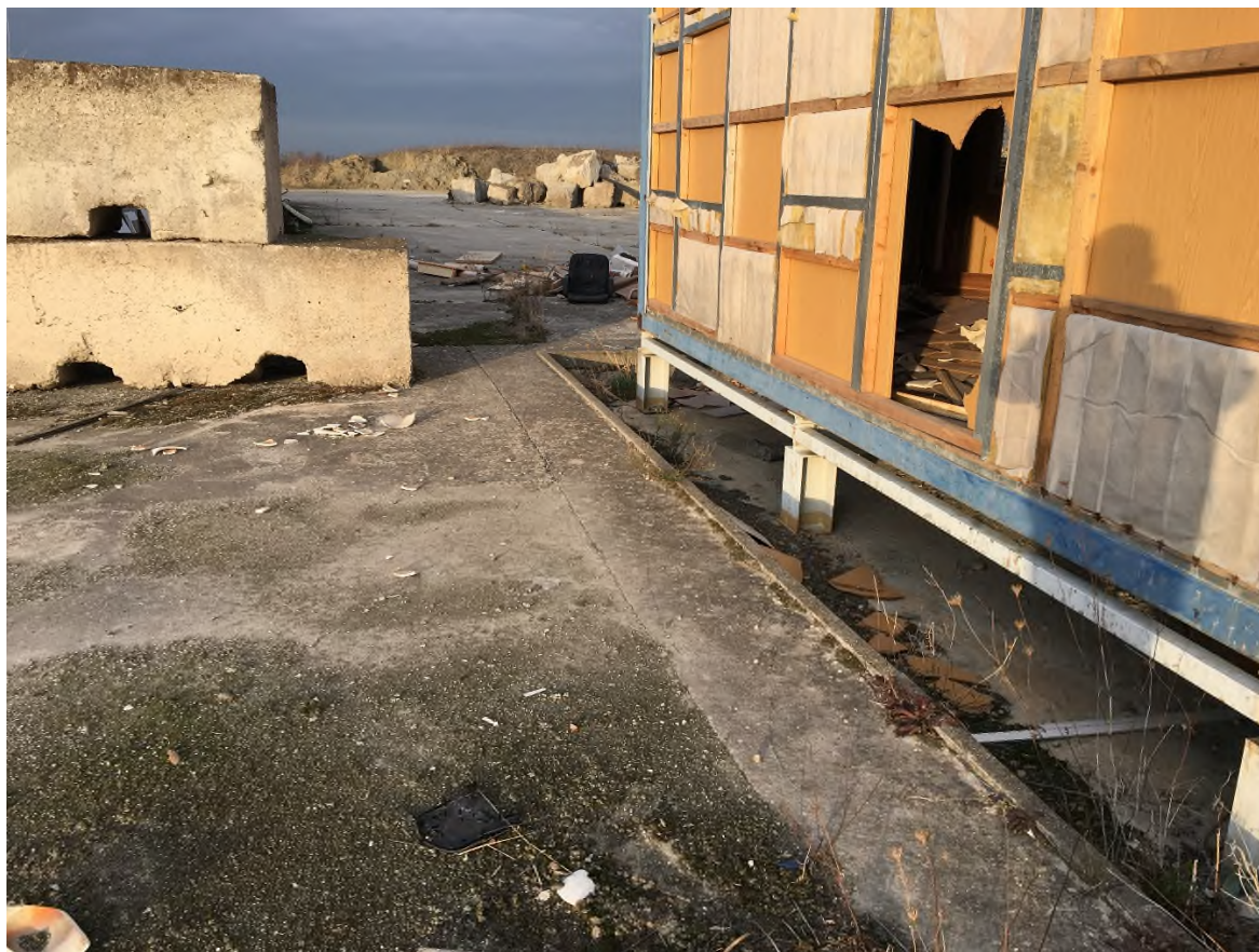
Bild 5: Anschluss Oberflächenversiegelung an ehem. Sozialgebäude, Blickrichtung West
