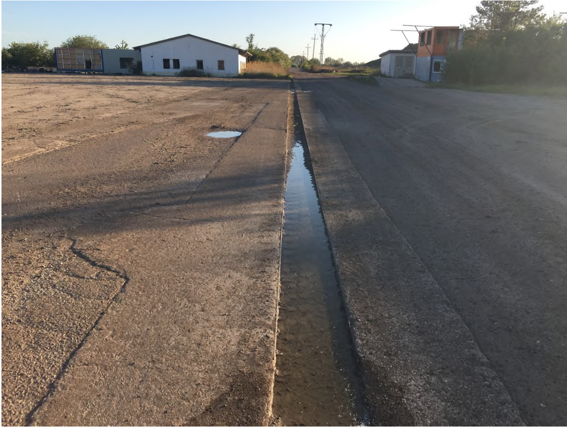
Bild 15: Östliche Sanierungsgrenze, Blickrichtung Nord
