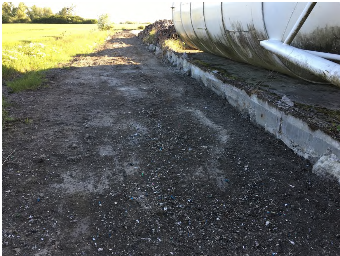
Bild 8: Westliche Sanierungsgrenze, Blickrichtung Nord (Hinweis: Stahl wurde entsorgt)
