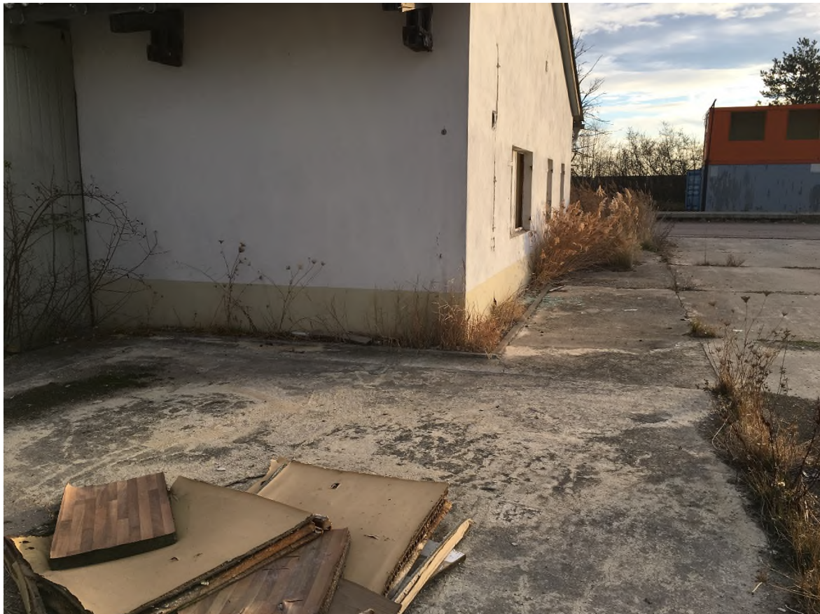
Bild 4: Anschluss Oberflächenversiegelung an ehem. Sozialgebäude, Blickrichtung Ost
